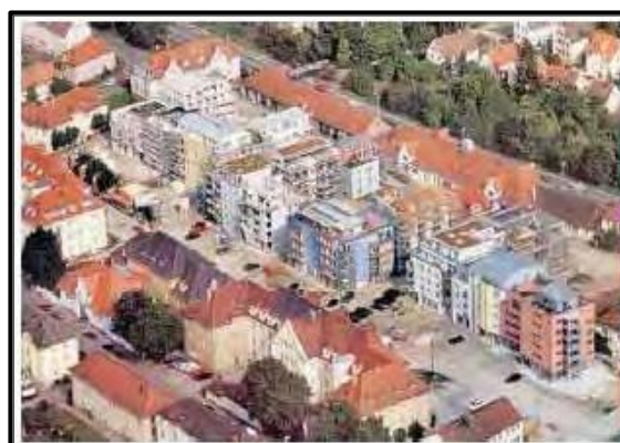
Figure 14 : Vue des premiers îlots en cours d'aménagement
