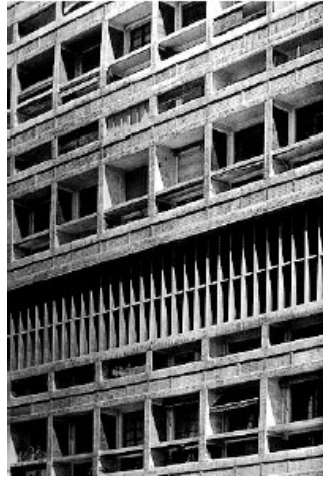
Fig. 29 : Unité d'habitation de Le Corbusier, Marseille, France 1947-1952. (Heyleghe, 2000)
