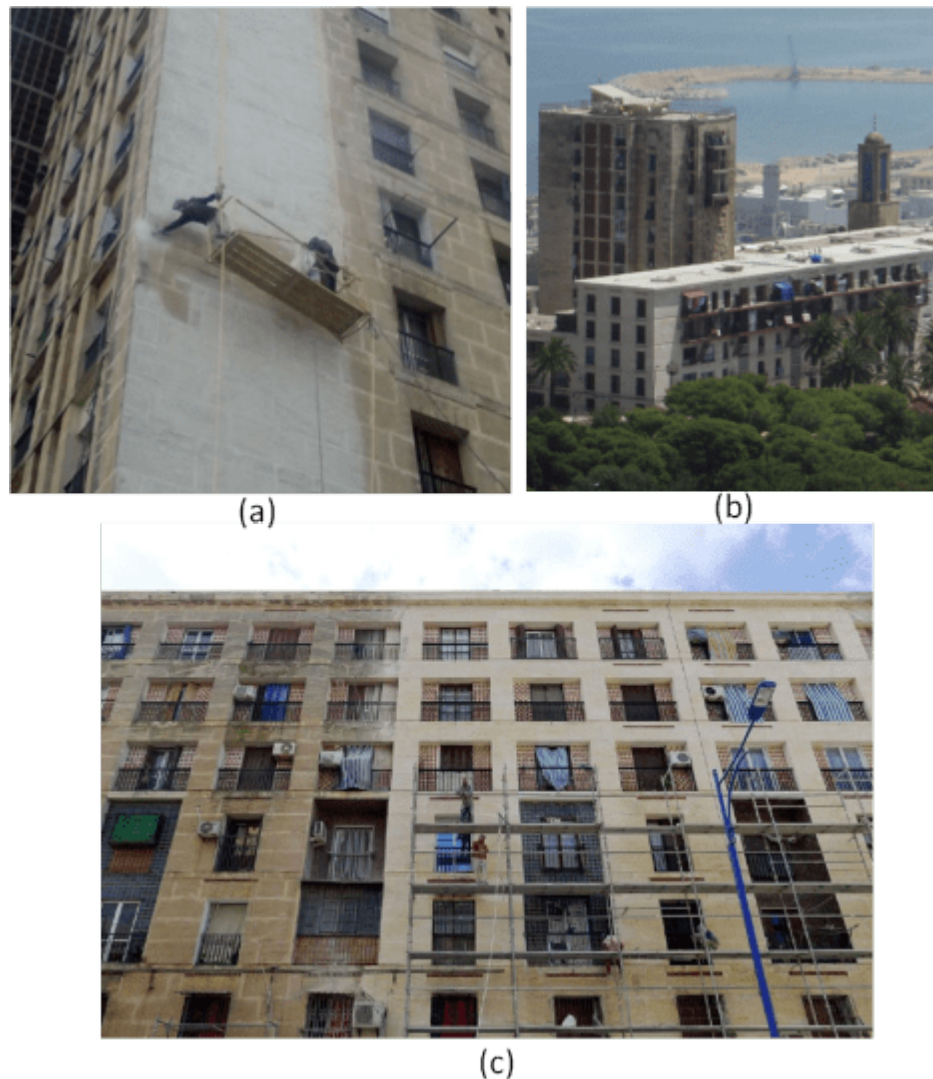
Figure 3. 15: Opérations de sablage des façades des grands ensembles : (a) Diar es Saada et (b, c) Diar el Mahçoul (photos prises en septembre 2018).
