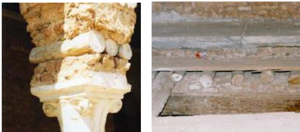
Figure 2. 7: Chapiteau articulé et plancher en bois avec une superposition de deux rondins, la Casbah d'Alger [75].
