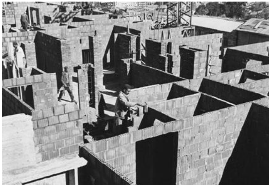
Figure 2. 14: Image prise dans le chantier Climat de France, dans laquelle figure les poteaux parasismiques.
