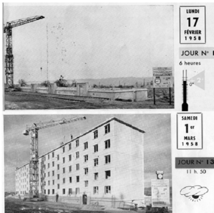
Figure 1. 5: Evolution de la réalisation de l'opération éclair à Saint-Etienne-du-Rouvray : le premier et le dernier jour [22].
