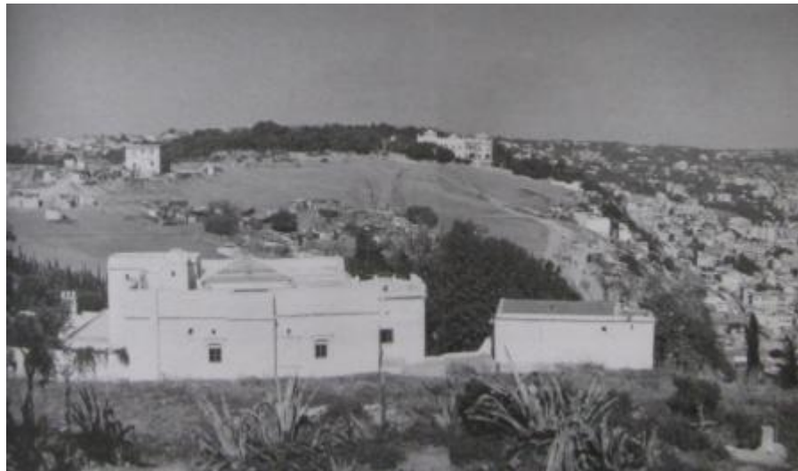
Figure 3. 6: Site d'implantation de Diar el Mahçoul, avec la villa des Arcades au premier plan [106].
