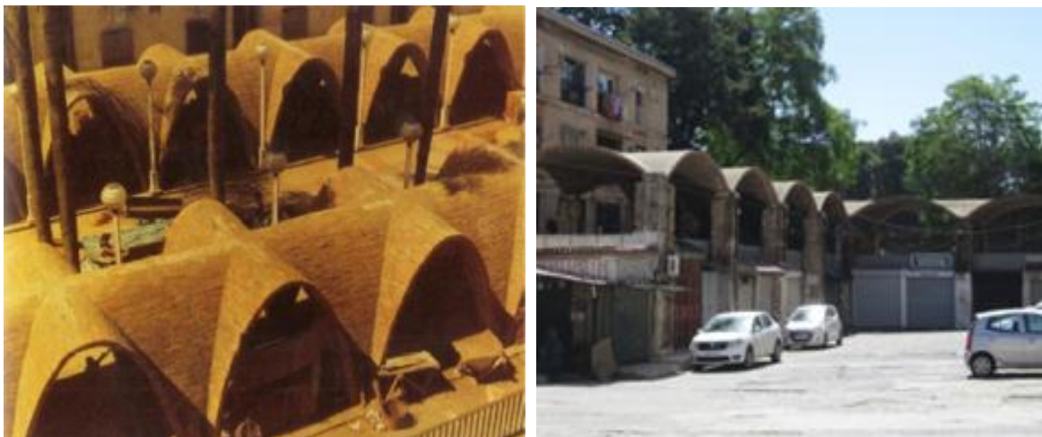
Figure 1. 14: Les voûtes d'arêtes croisées de la place du marché Diar el Mahçoul et Diar es Saada [44].
