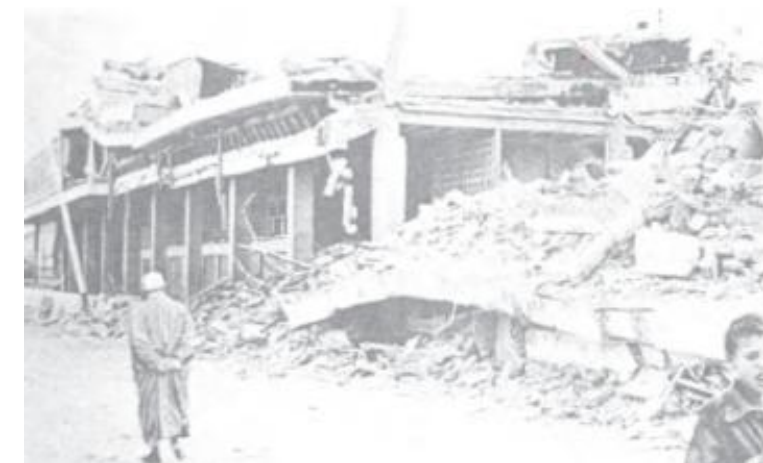
Figure 2. 9: L'effondrement des structures en béton armé, séisme de Chlef de 1954 [40]
