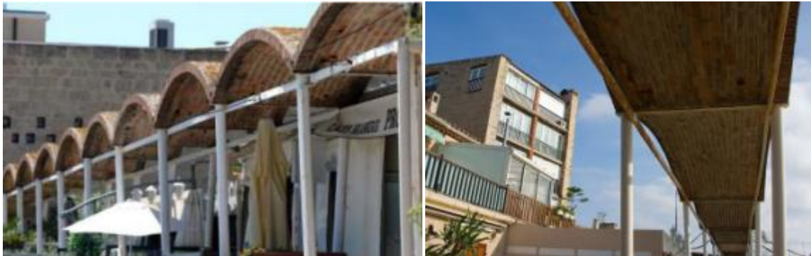
Figure 1.13: Le hameau des Sablettes (1953) [43], les galeries couvertes surmontées de voûtes en briques creuses ; les passages couverts des cités algériennes ou des Sablettes.
