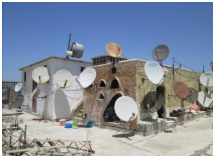
Figure 5. 14: Les modifications apportées à la terrasse de la tour.
