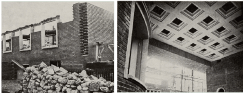
Figure 1.3: Le groupe d’habitation HBM en cours de construction et vue du plancher à caissons [30].
