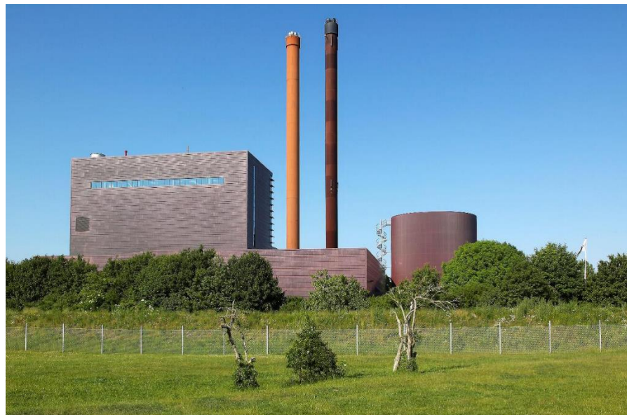
Figure 1.23 Centrale de cogénération de Skyve en Autriche
