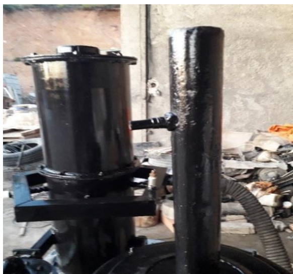
Figure 4.11 Piquage pour collecter des échantillons du syngaz
