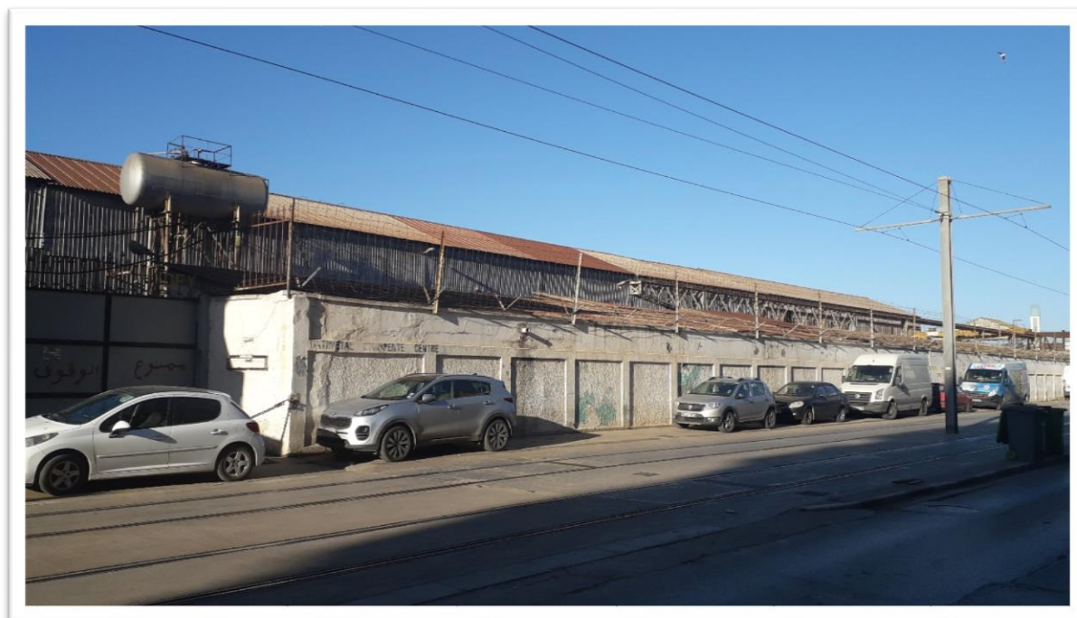
Figure A 11: Différentes Images sur l'axe Tripoli d'Hussein Dey démontrant le rétrécissement de la voirie, manque de chaussée pour les piétons et places de stationnement
