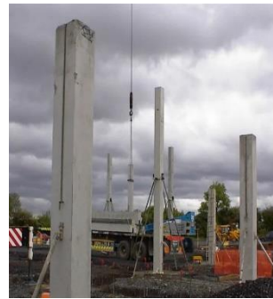
Figure 81: Poteaux rectangulaires en béton armé.
