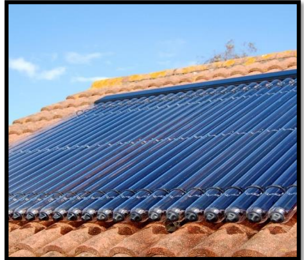
Figure93 : Panneaux solaires thermiques Source : https://lajoliemaison.fr/comparatif/le-meilleur-panneau-solaire-thermique/
