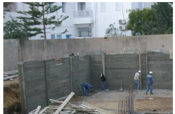
Figure 83: Voiles en béton armé.
