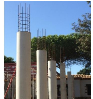
Figure 82: Poteaux circulaires en béton armé.
