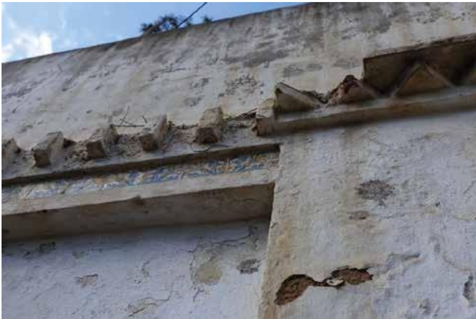
Fig.38 : Façade extérieur (mur de clôture) du Haouch.
