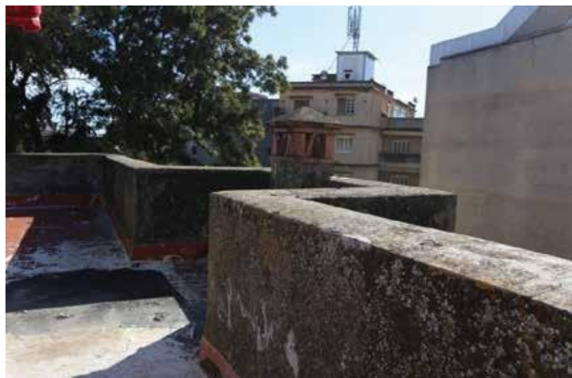
Fig.34 : Mur de 40cm en guise de garde corps sur terrasse.
