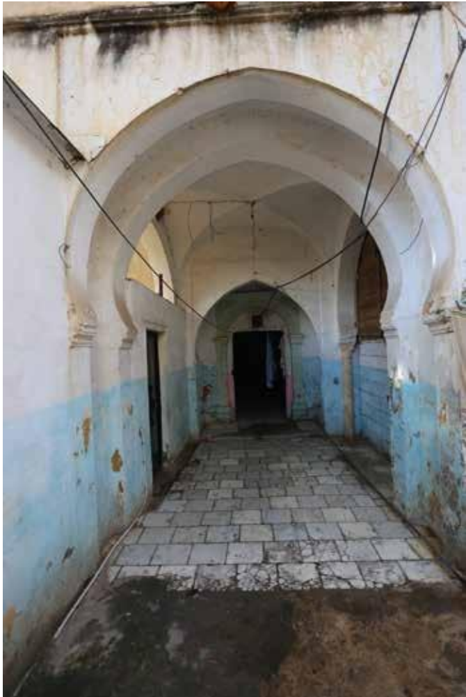
Fig.16 : Revetement en Marbre a l'entree du Haouch.
