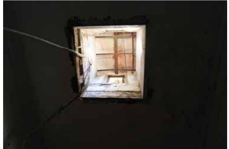
Fig.56 : Puits de Lumiere centrale au niveau du Plafond du 1er etage.
