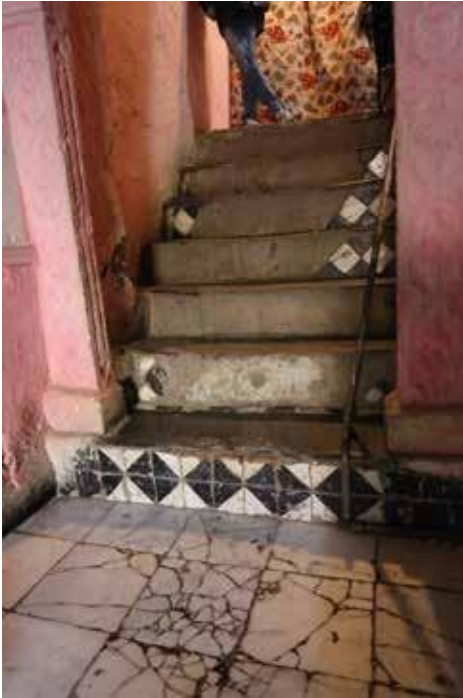
Fig.52 : Vue Les escaliers (Marches/ contre marches).
