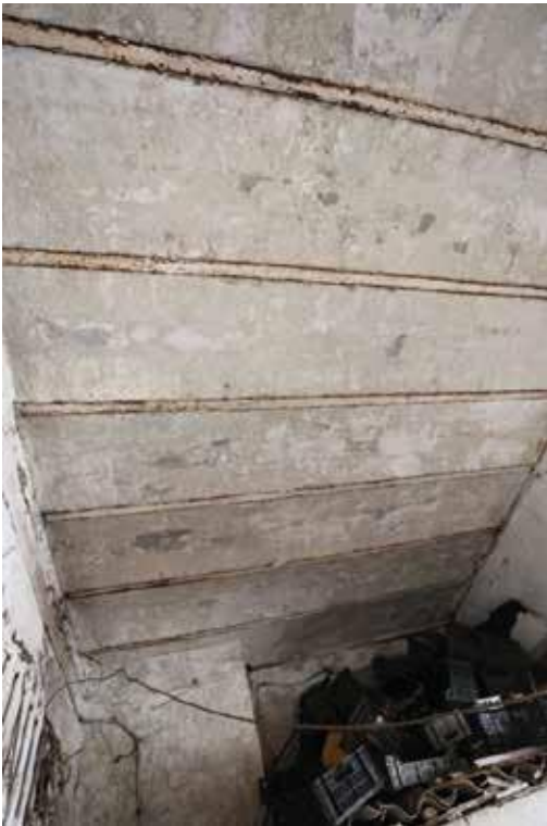
Fig.50 : Vue sur un Plafond en Moullion a l'entree du Haouch.
