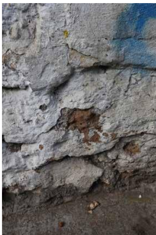
Fig.13 : Liant sur mur d'entree.
