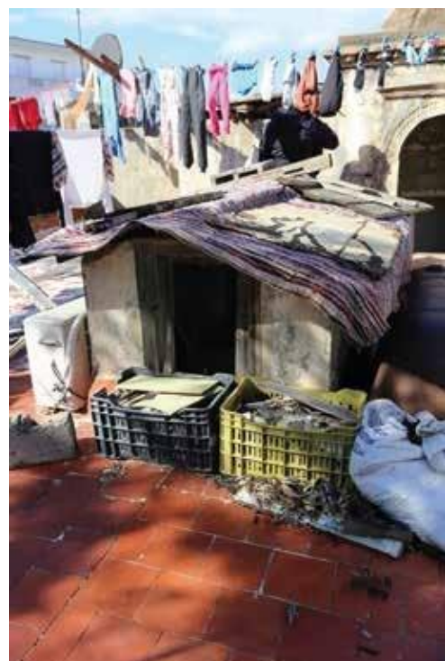
Fig.58 : Puits de Lumiere centrale au niveau de la terrasse.
