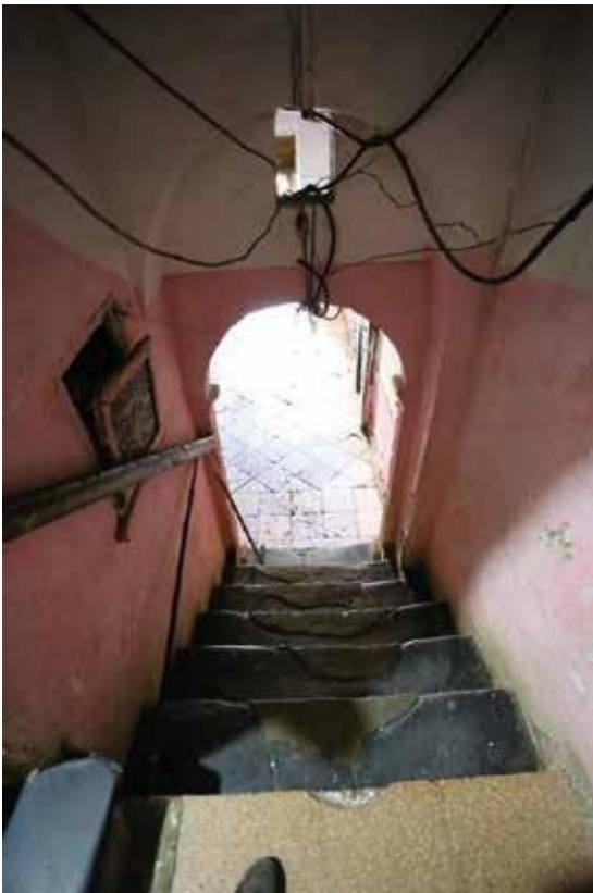
Fig.53 : Vue interieur sur la cage d'escalier.
