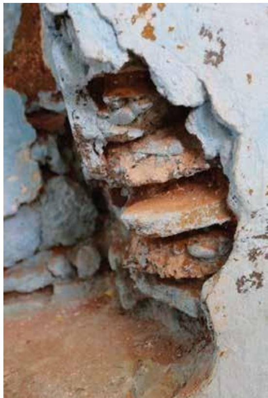
Fig.11 : Liant et pierre d'un mur sur l'entree de la maison (Patio).
