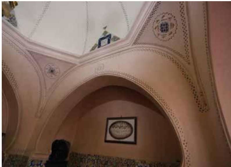
Fig.63 : Arcature au niveau de la chambre principale .
