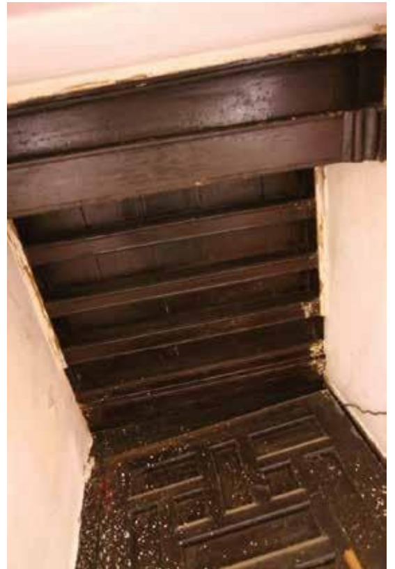
Fig.23 : Toiture en Bois au niveau de la cage d'escalier.
