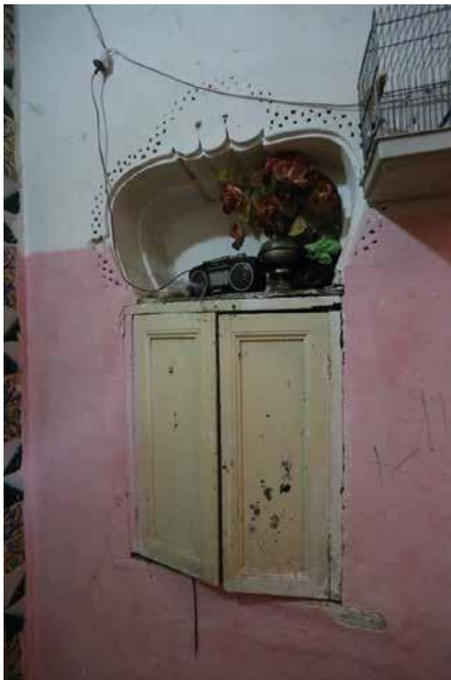
Fig.61 : Croquis sur une niche au niveau du Hall du 1er etage .
