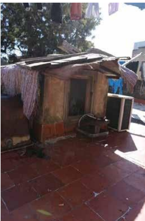
Fig.57 : Puits de Lumiere centrale au niveau de la terrasse.
