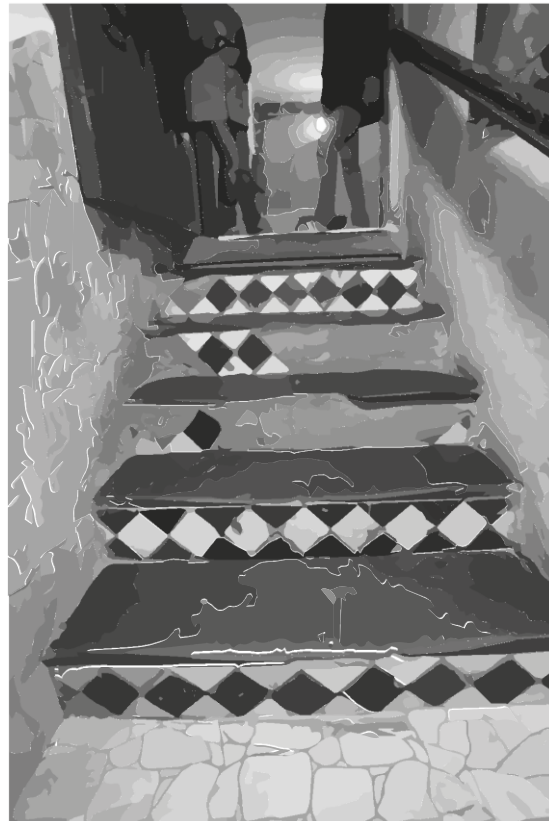
Fig.54 : Vue Les escaliers (Marches/ contre marches).
