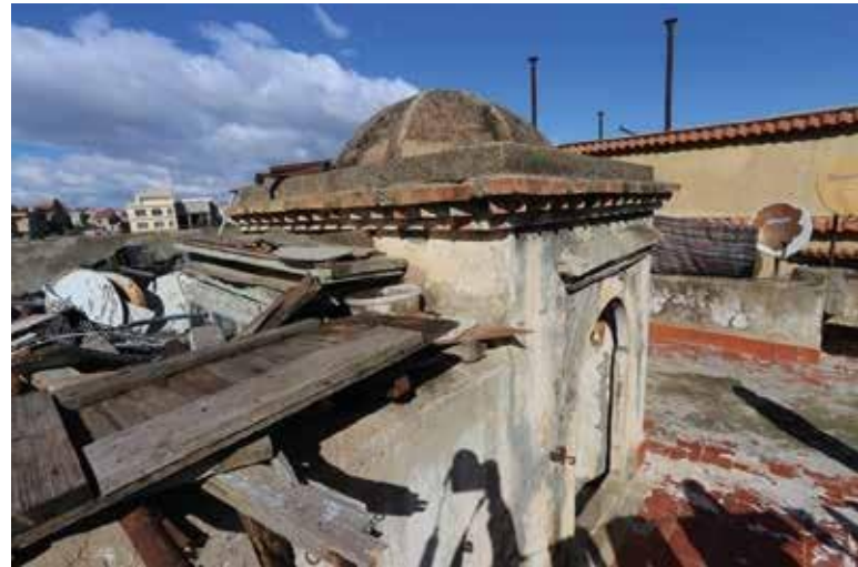
Fig.44 : Vue sur La toiture de la cage d'escalier & sa coupole.
