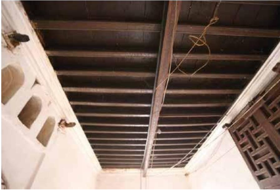
Fig.18 : Profilé sous le plafond pour soutenir le plafond en bois (R'ajout de la période coloniale).
