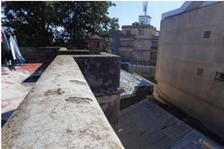
Fig.46 : Vue sur Le garde corps de la toiture et du voisinage direct.
