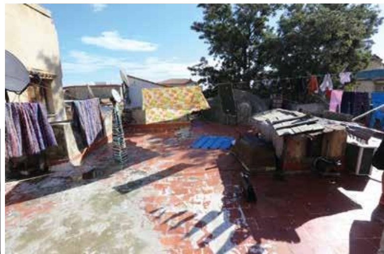
Fig.45 : Vue sur Le plancher de la toiture & du puits de lumière.
