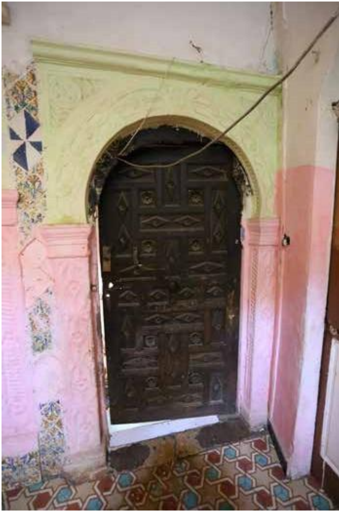
Fig.67 : Porte d'entrée vers le Hall du 1er etage .
