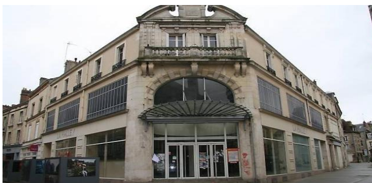
Figure 9 : Bâtiments commerciaux en friche à Alençon Source : https://www.ouestfrance.fr/normandie/alencon-61000/les-friches-commerciales-seront-taxe-es-3304294
