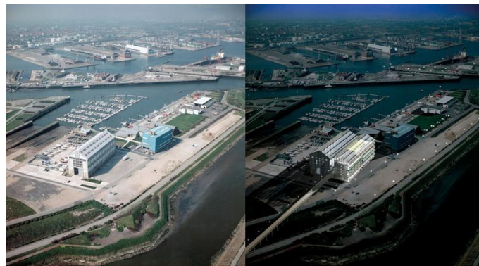
Figure 43 : bâtiment du Frac /AP2
