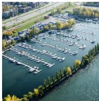
Fig42. : Port de plaisance de
