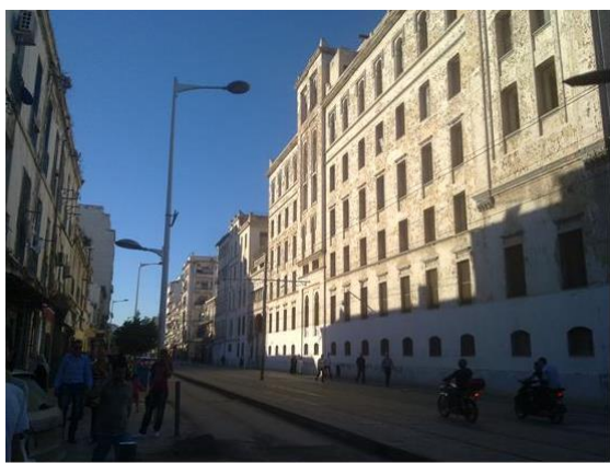
Figure 12 : Minoterie Narbonne Source : Travail d'atelier Arviter
