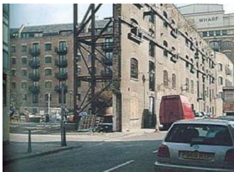
Figure 19 : « Façadisme » pour la reconversion d'un immeuble des docks en bureaux
