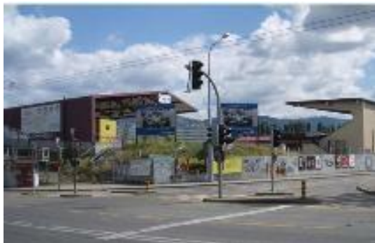
Figure 10 : Friche infrastructurelle à Genève Source : https://www.ecoparc.ch/fileadmin/user_upload/resources/Forum07_Rey.pdf
