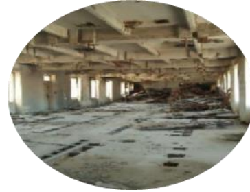
Fig.59 : Anciennes salles des machines
