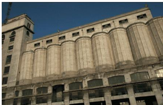
Figure 21 : Le silo à blé d'Arenc de Marseille vue de l'extérieur, Source : http://www.castaldiarchitecte.com/uploads/tumbnails/gallery/picture/zoom/cb306da4bce97bbd182efa562b8aef5d0bc4f136.gif
