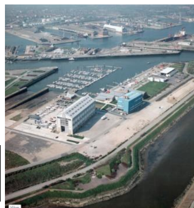
Figure 44 : Le hall des Ancien Chantiers Nadal de France Source : http://www.lacatonvassal.com/index.php?idp=61
