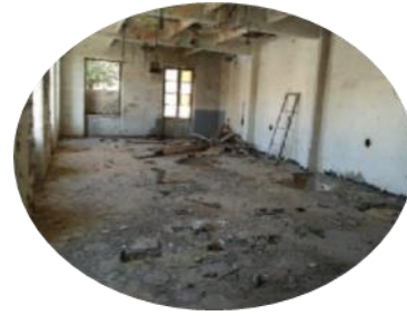
Fig58. : Anciennes salles des silos de blé
