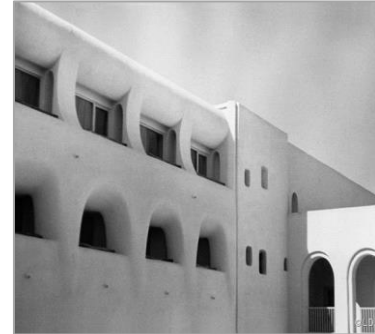
FIG 4.64 : Façade de l'hôtel..
