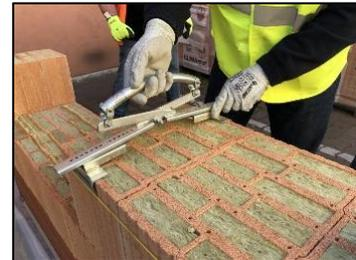
Figure 116 : brique mono mur à isolation intégrée. Source : Batirama.com.
