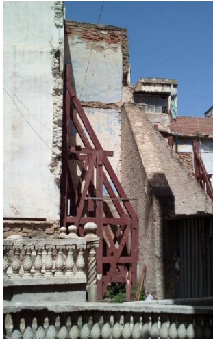
Figures 8 et 9 : les confortements – mesures d'urgence. Source : Auteur, le 16.05.2021.
