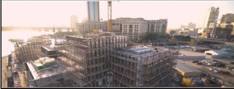
Figure113 : photo lors de la construction de l'équipement
