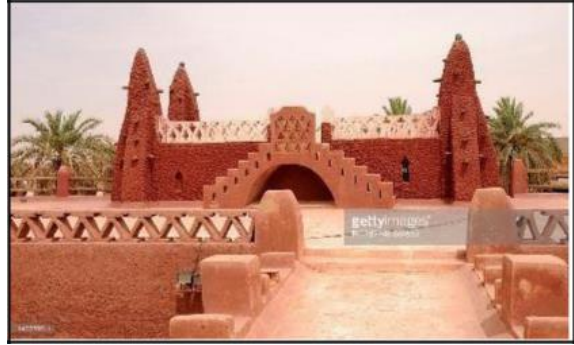
Figure118: L'étage du centre Source : https://images.app.goo.gl/o6yhD69YJBqMXo1C7
