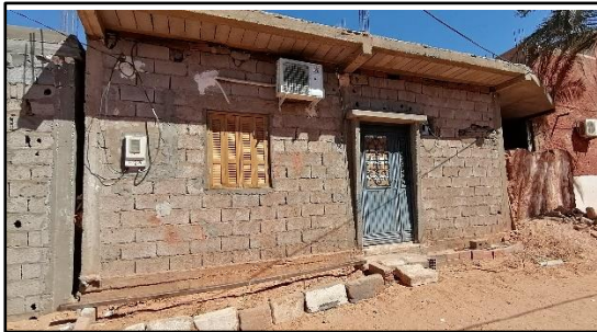
Figure 94 : maison individuel en RDC, Touba Timimoun. Source : auteur2020.
