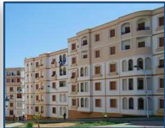
FIGURE 1.19 : LOGEMENT A TAMANRASSET
