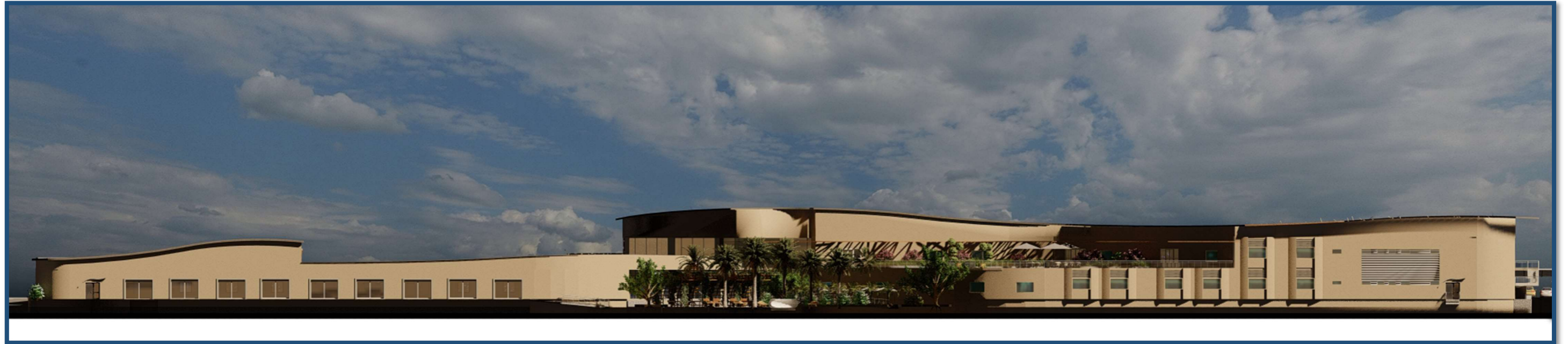
La Façade Principale du Centre de Formation et de Production de la Poterie Noire
