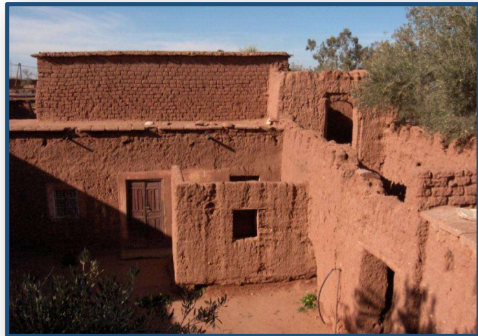
FIGURE 1.14 : Maison en terre crue à Marrakech, Maroc.
