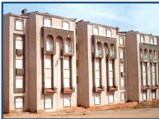
FIGURE 1.19 : LOGEMENT A TAMANRASSET
