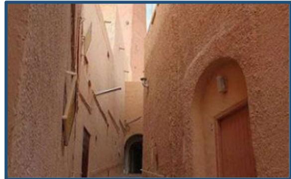
FIGURE.4.6 : Traitement des surfaces en crépi à Ksar Beni Izguen, Ghardaia, Algérie
