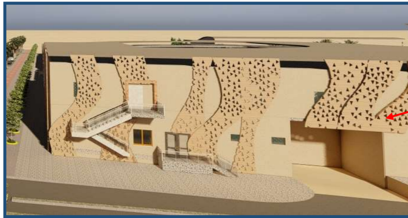
FIGURE 11. 23: Photo de la façade Ouest du centre commercial.
