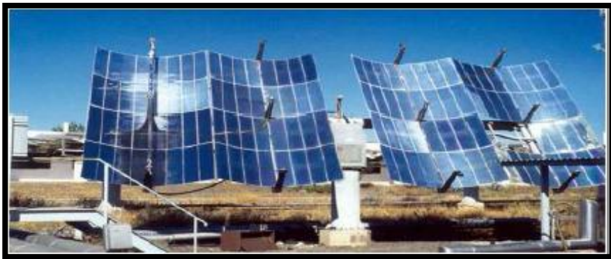
Figure (1.14): Capteur solaire à concentration en auge parabolique doté d'un système de suivie du soleil à deux axes.
