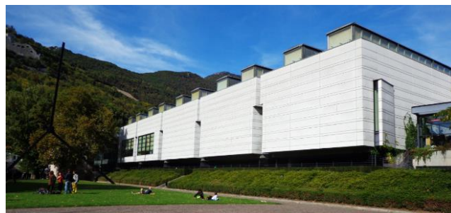
Figure 1.13 : La façade géométrique droite (Source : khadraoui 2019)
