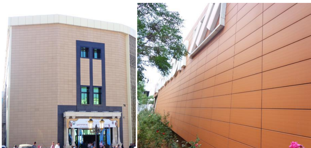
Figure1.32: Façades ventilées avec joints fermés (Source : khadraoui, 2019)
