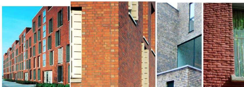
Figure 1.18 : Façade en brique (source khadraoui 2019)
