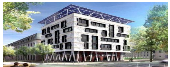
Figure 2.3: Bureaux à énergie positive, ZAC de bonne, Grenoble.
