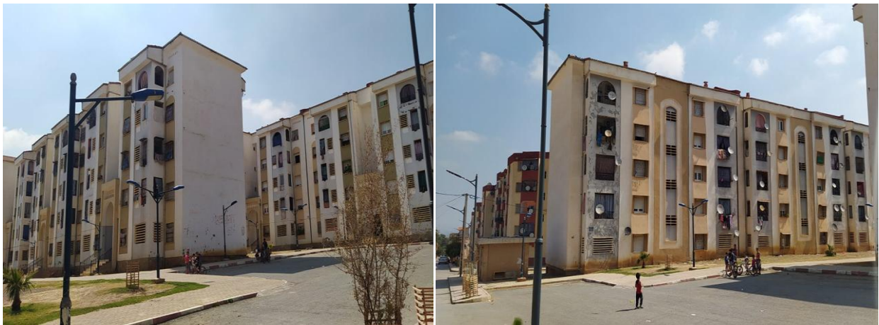
Figure 3.9 : Vue du 80 logements HPE source : auteur (juillet 2020)
