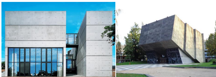
Figure 1.19 : Façade en béton armé (Source : khadraoui, 2019)
