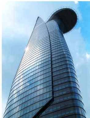
Figure1.21: Façade en verre (Source : khadraoui, 2019)
