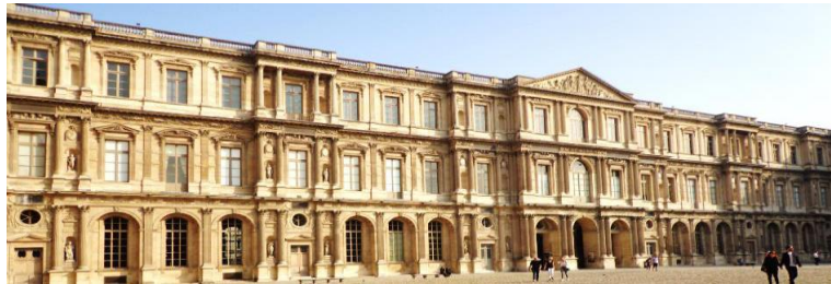
Figure1.17: Façade en pierre (Source : khadraoui, 2019).
