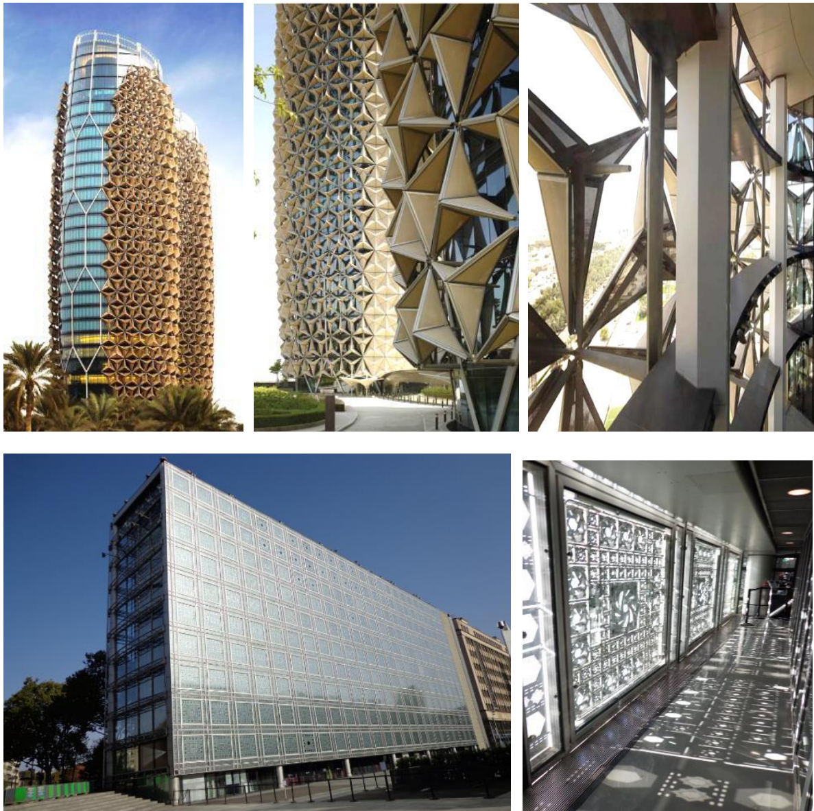
Figure1.45 : Exemple des façades adaptatives .(Source : khadraoui 2019)
