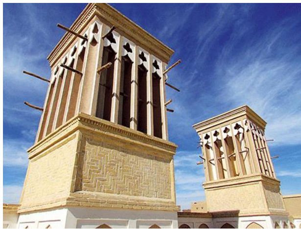
Figure 6: Fonctionnement de badgir source : http://primoinedorient.org et le site : Whc.unesco.org
