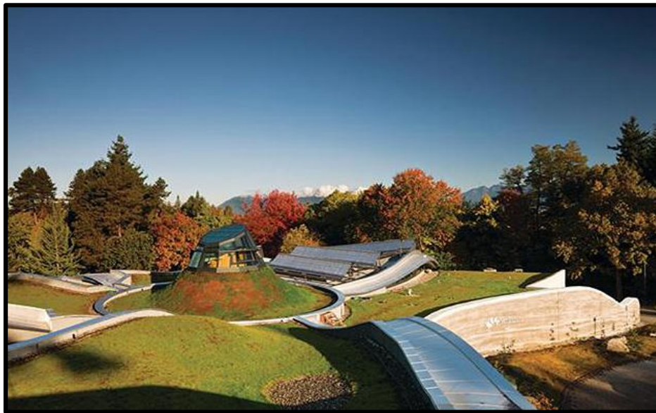
Figure 27: Vue sur la toiture du centre /Source : https://fre.architecturaldesignschool.com
