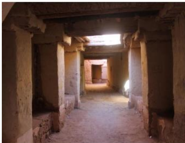
Figure 14:El douroub dans le ksar
