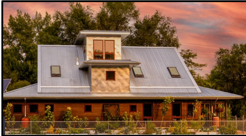
Figure 22:La façade de la maison
