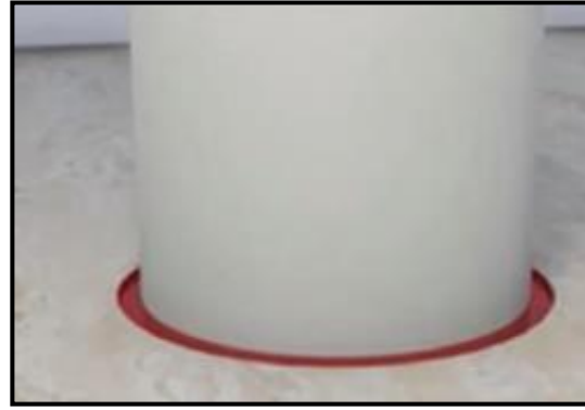
Figure 15: Le joint entre le plancher et l'auditorium de CIC d'Alger. Source : http://www.youtube.com
