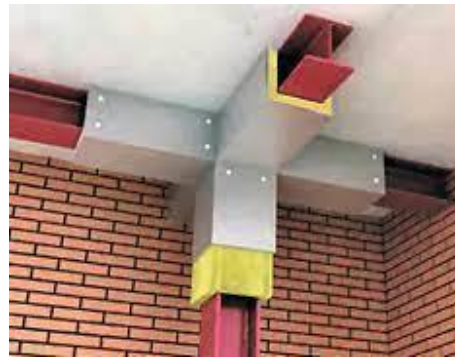
Figure 97: poteau métallique enrobé. Source : http://rockwool.gabon.prix-construction.info
