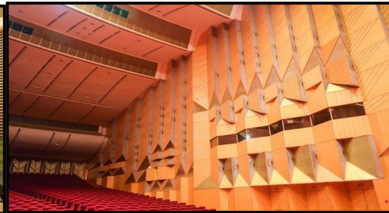
Figure : traitement acoustique. 84
