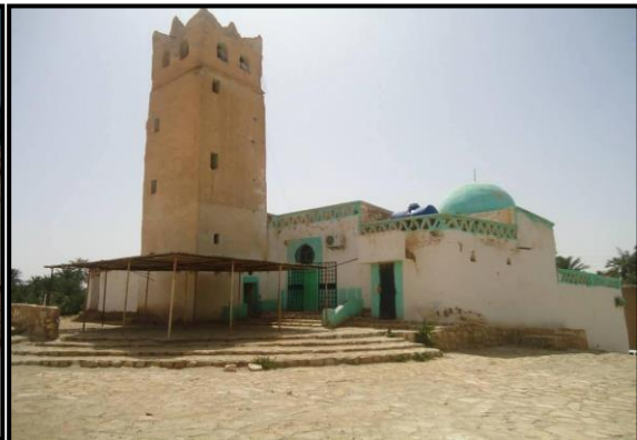
Figure : vue sur la mosquée Source : association Affak de Chetma.
