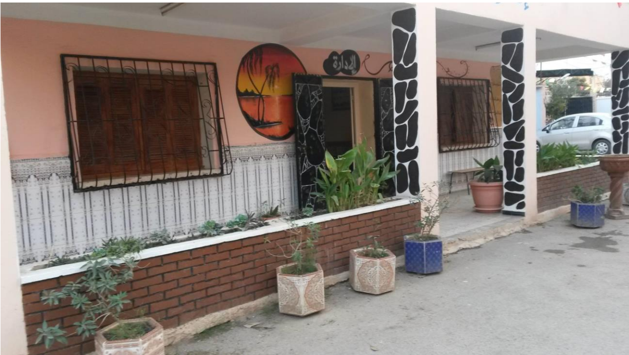
Figure 59 vue sur l'administration de l'école secondaire Hai El Mourabidine, Source : réseaux sociaux de l'établissement.
