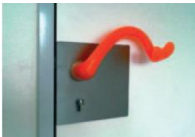
Figure 38 : poigné contrasté et facilement préhensible, Source : Norme de conception d'écoles accessible.
