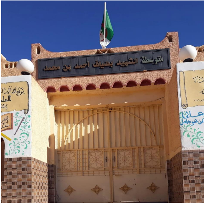
Figure 62 vue sur l'accès principal de l'école secondaire Boudiaf Ahmed Ben Mohamed , Source : réseaux sociaux de l'établissement.
