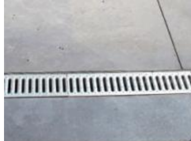
Figure 21 : fente de moins de 1cm. Source : Guide d'aide à la construction
