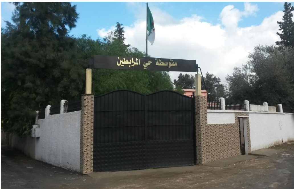
Figure 57 vue sur l'entrée de l'école secondaire Hai El Mourabidine, Source : réseaux sociaux de l'établissement.
