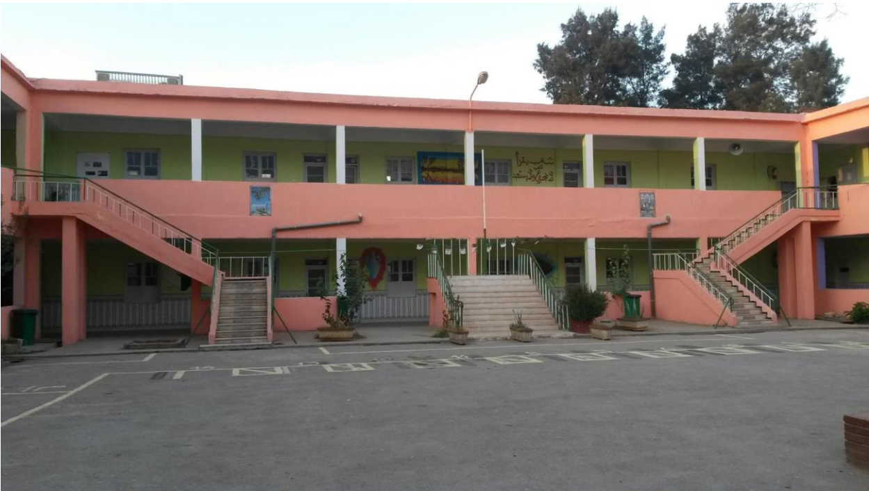
Figure 58 vue sur la cour de récréation et les blocs de classes de l'école secondaire Hai El Mourabidine, Source : réseaux sociaux de l'établissement.
