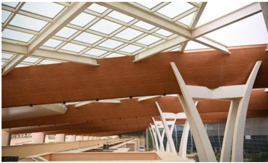
Figure 2.17 : la structure de Centre International des Conférences d'Alger (CIC).
