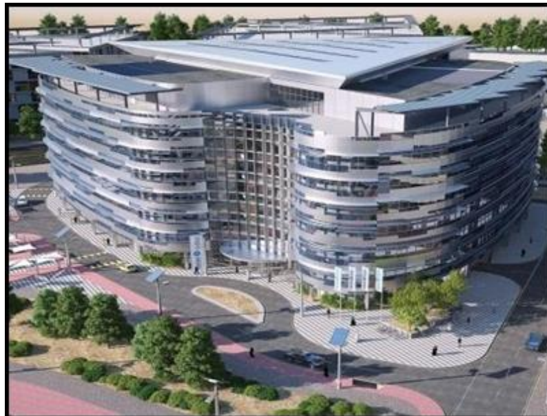
Figure 4.12 : Siège de Masdar, Abu Dhabi. Source : Www ; laidlaw gulf Llc ; com.
