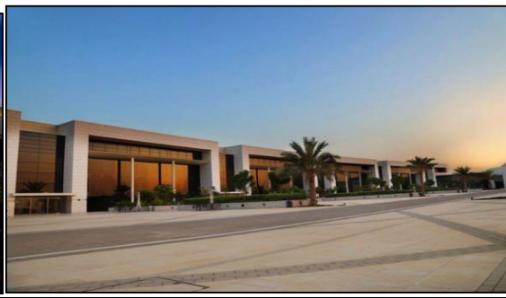
Figure 2.28 : façade bloc d'exposition Source : http://omanall.com/
