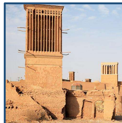
FIGURE.4.14 : Tours à vent à Yazd en Iran
