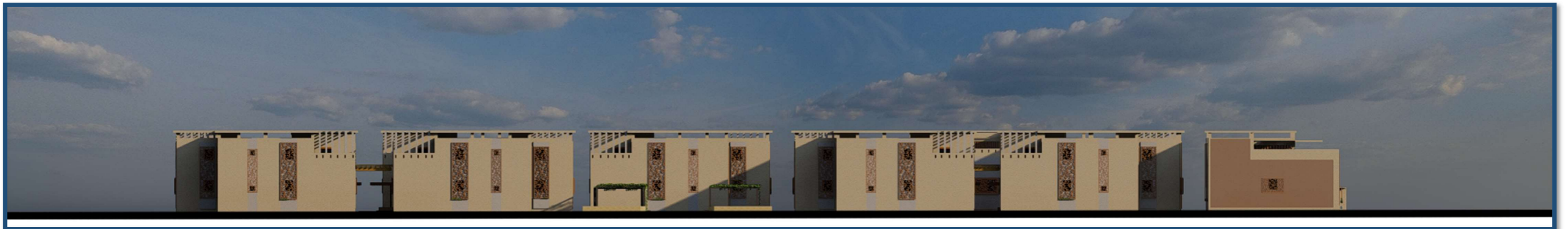
Façade Intérieure coté Nord-Est
