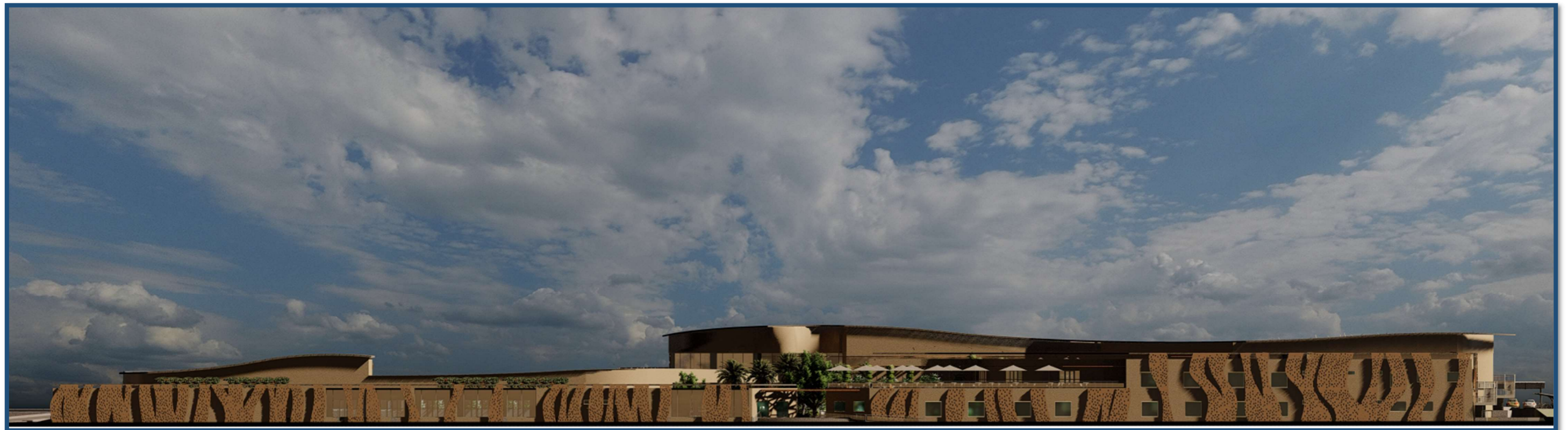
La Façade urbaine (Principale du Centre Commercial)
