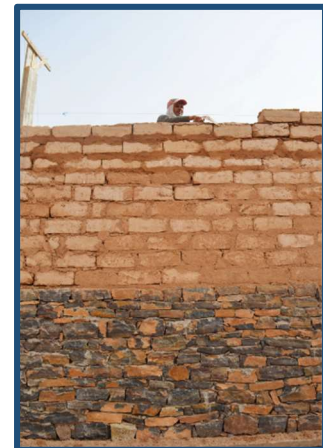
FIGURE.4.5 : Construction à Souss Massa, Maroc
