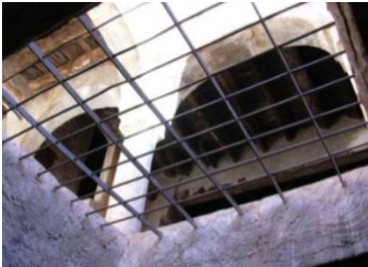
FigureII-9: Pénétration de l'air frais et de l'éclairage naturel à travers le chebek Source : https://b-nour.jimdofree.com
