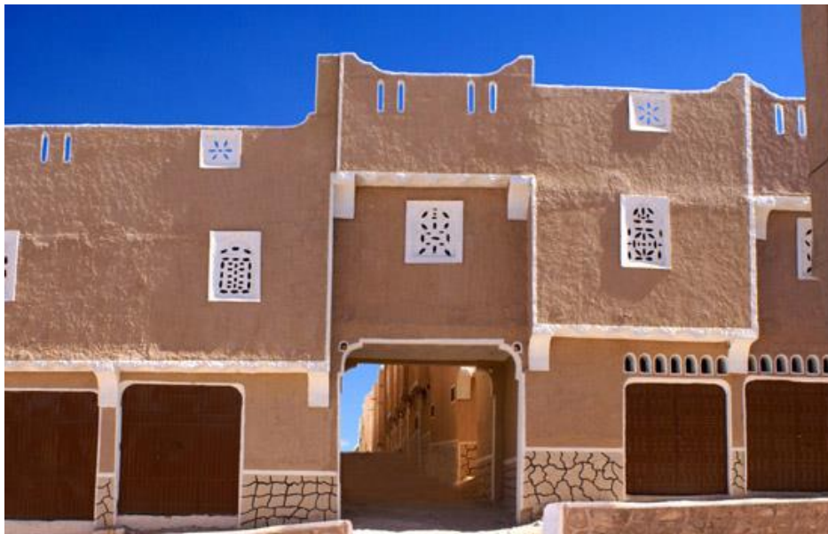
Figure : La texture et les ouvertures des façades du Ksar Tafilelt
