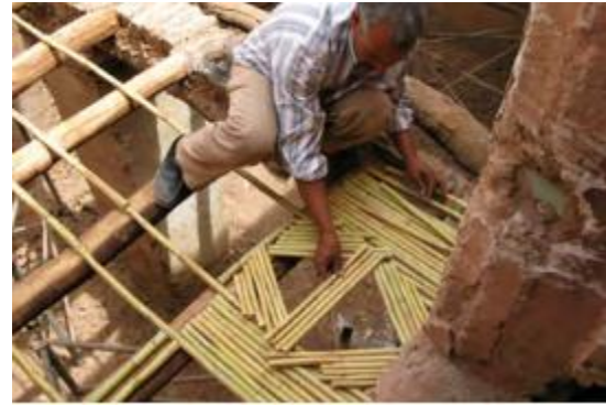
Figure : Le roseau pour le plafond
