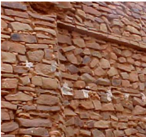
FigureII-16 : Mur en pierre à Kenadsa Source : https://www.pierreseche.com
