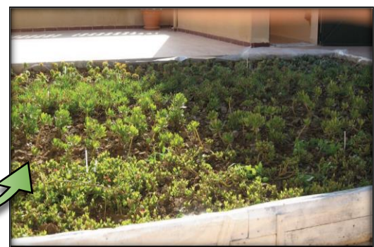
Figure 57: Aspect de la toiture végétalisée
