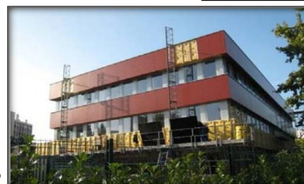
Figure 50 : Photos du bâtiment de l'ALLP
