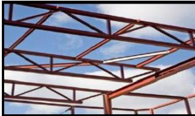
Figure59 : photo d'une poutre treillis structure métallique des serres
