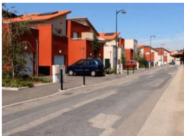
Figure02 : Logements sociaux construits dans le Quartier des écoles, à Taluyers. Source : Syndicat de l'Ouest Lyonnais
