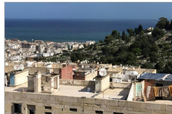
Fig 55 : terrasse d'un immeuble de la cite climat de France
