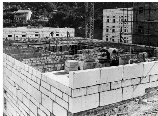
Fig.(84): Chantier de climat de France lors de la construction des murs de séparation intérieurs et les murs porteurs en pierres.
