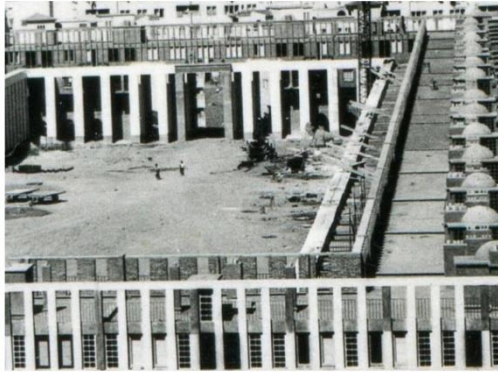
Fig(77): Vue sur l'immeuble de 200 colonnes montrant les coupoles sur le toit Source : fernandpouillon. com crée par l'association « les pierre sauvages de Belcastel
