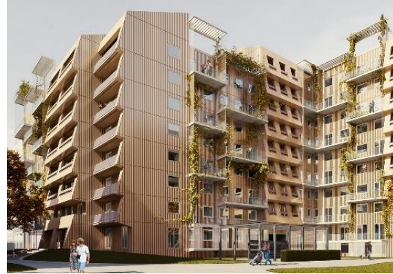
Fig 35:Photo montrant les façades réhabilitées du bâtiment/après Source: http://puechsavoy.com/Quartier-de-Arlequin-Grenoble.html
