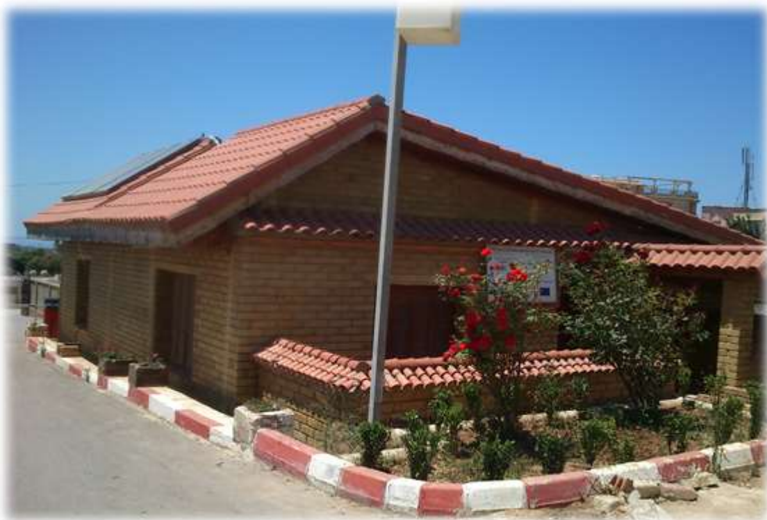
Figure III.1. La maison prototype situé au CNERIB (à Souidania)
