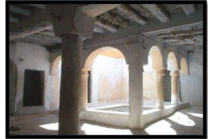
Figure 21: Le patio d'une maison à Ghardaïa. Source : google image.
