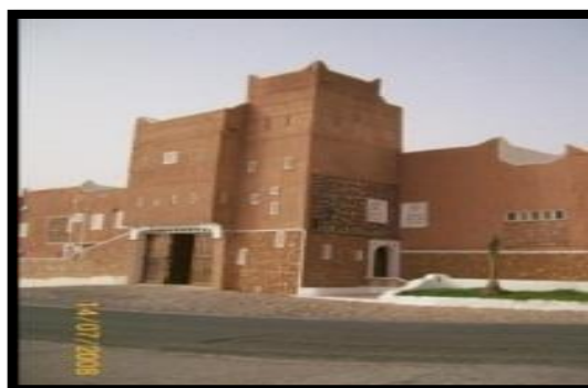
Figure 70: Entrée urbaine du Ksar de Tafilelt. Source : google image.
