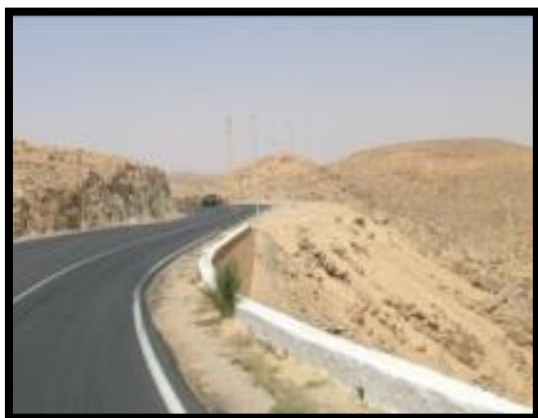
Figure 95: La route nationale N°1 Source : google image.
