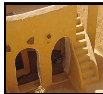
Figure 28: La chaux. Source : OPVM.
