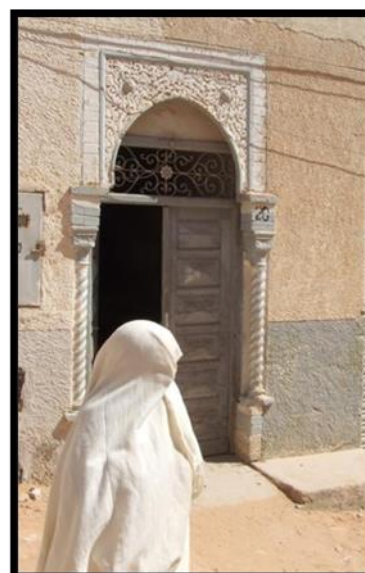
Figure 41: Porte d'entrée ouverte à Ghardaïa.
