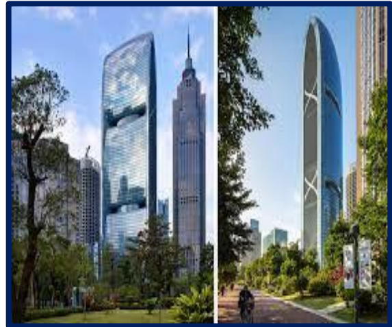
Fig. II 19 : Pearl River Tower par skidmore
