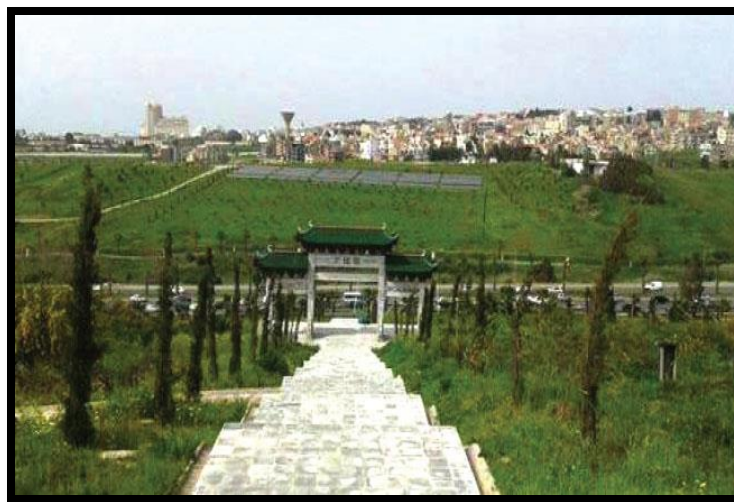
Figure 2 - 8 : Vue sur DOUNIA parc. (Source : https://www.algerie-focus.com )
