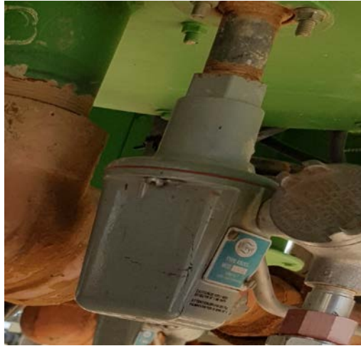
Figure II.6 Détecteur de flammes UV.
