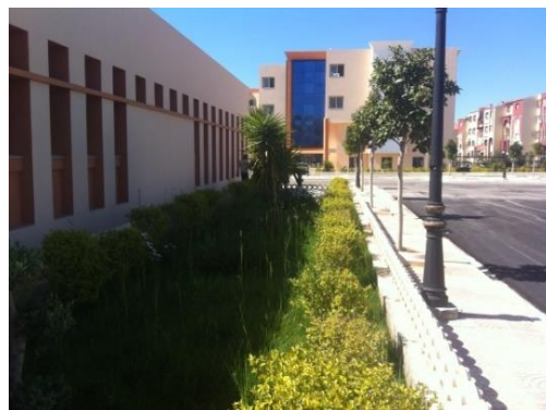
Figure 33 : Hôpital Remchi, Tlemcen. Source : http://www.eph-remchi.dz/index.php/accueil
