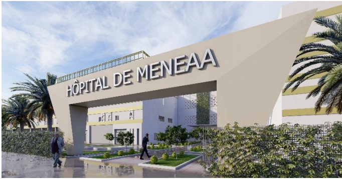
Figure 88: vue sur façade donnant sur le boulevard. Source : Auteurs, 2021.
