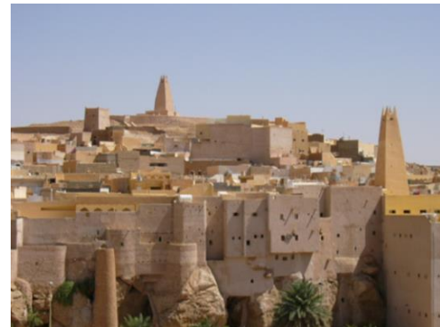
Figure 08 : Les mosquées, Ksar Beni Isguene, Ghardaïa, Algérie / Source : http://ont.dz/visiter-lalgerie/le-mزاب/
