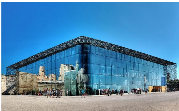
Traitement des façades nord et Est en verre, Source : http://monumentsdemarseille.com/mucem
