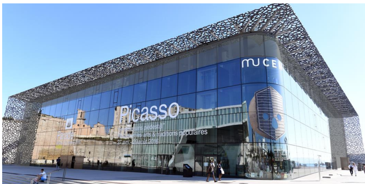
Réflexion de l'ombrage que projette la résille sur le mur rideau Source : culturebox.francetvinfo.fr
