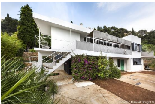
Vue sur la Villa E 1027 à partir du jardin Source : wikiarquitectura.com
