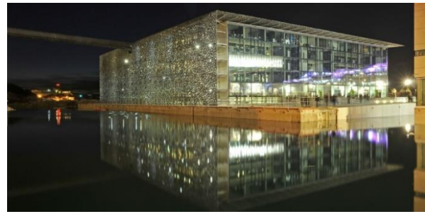
Résille en béton armé s'étendant sur la partie nord Source : www.office-et-culture.fr
