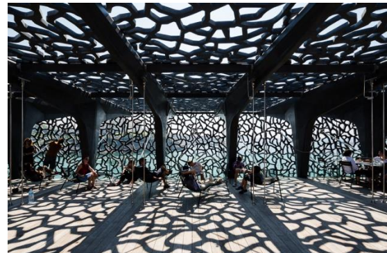
Jeux de lumière apportée par la résille en béton sur la terrasse.
