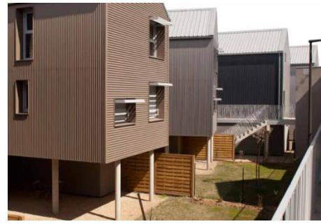
L'espace situé sous les pilotis est attribué à chaque logement
