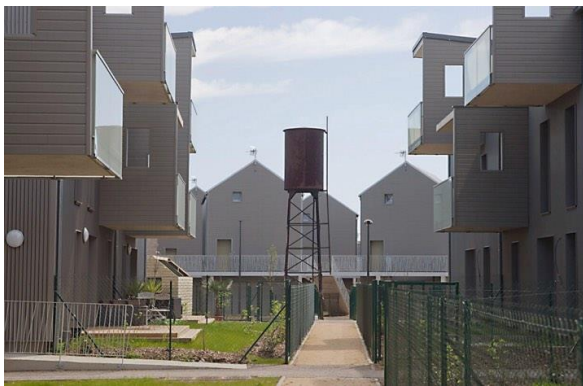
Passerelles permettant la circulation et assurant la sécurité en cas de crue
