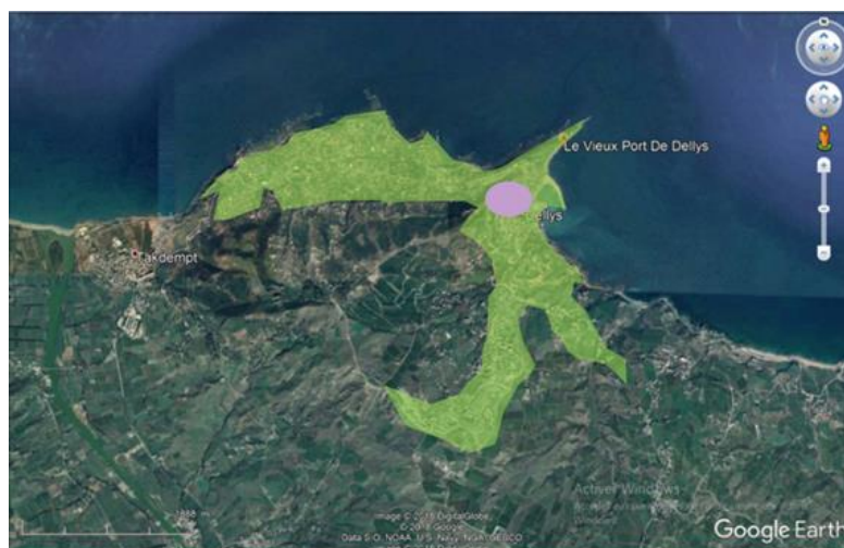
Vue satellitaire du développement de la ville de dellys Source : Google earth
