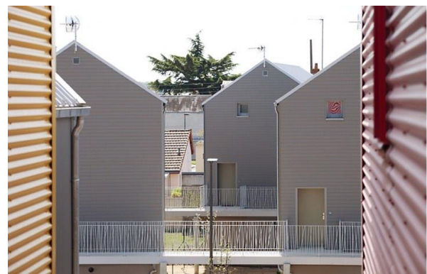
Passerelles permettant la circulation et assurant la sécurité en cas de crue
