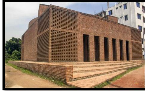
figure 05 : construction en BTC
