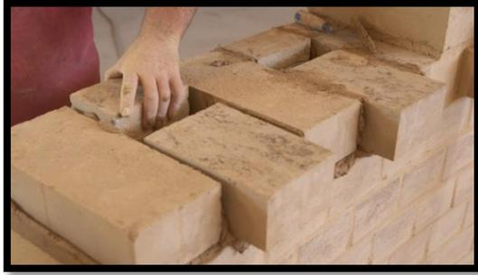
Figure04: brique de terre compressée
