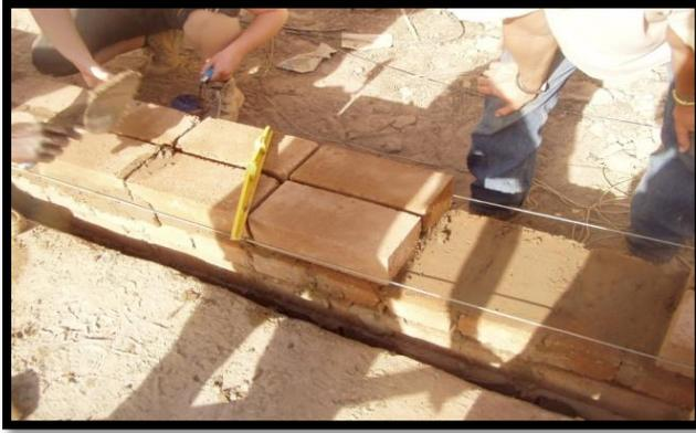
**Figure 06: montage d'un mur avec le BTC**
