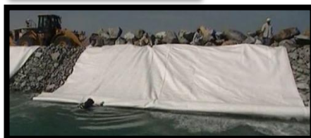
Figure 115: réalisation de la digue de protection
