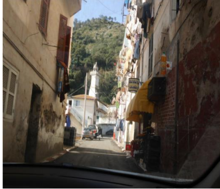
L'état du bâti du village de Stora.
