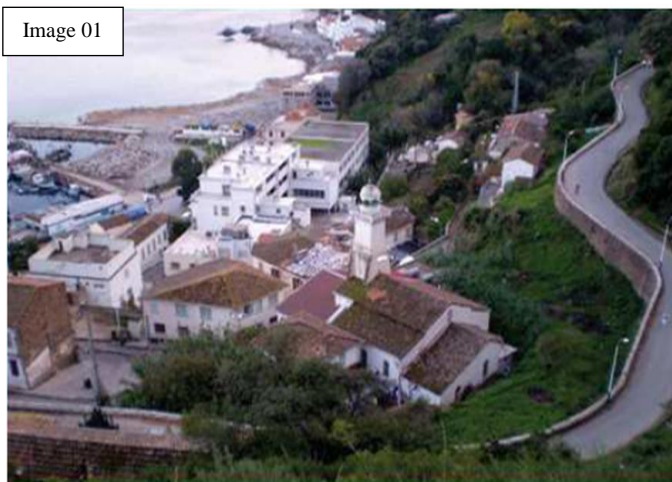
Le village de Stora et la route supérieure menant à Grande Plage.
