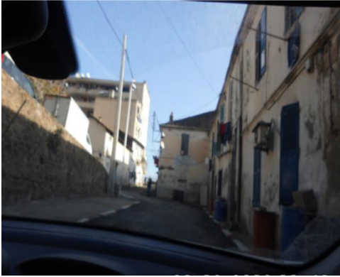
L'état du bâti du village de Stora.
