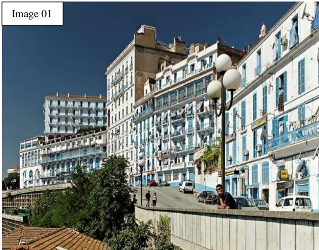
Image 01 : Le bleu et le blanc dans les façades dans la ville de Bejaia.
