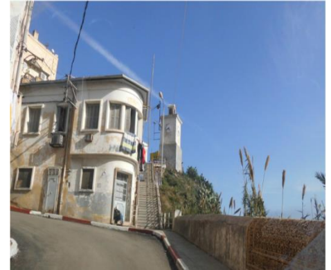
L'état du bâti du village de Stora.
