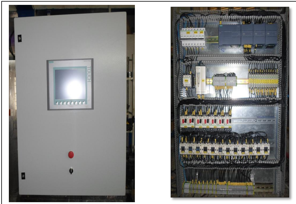
Figure 2.13. Constitution d'une armoire électrique.
