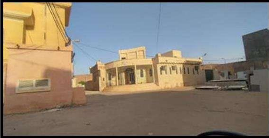
Figure 12 : édifice à Atteuf ,Ghardaia Source :Google Earth
