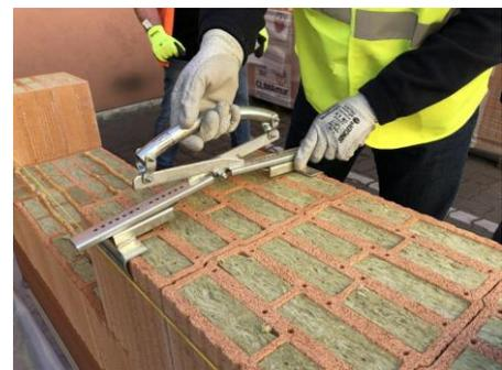
Figure 79: mise en oeuvre de la brique monomur. source: google images
