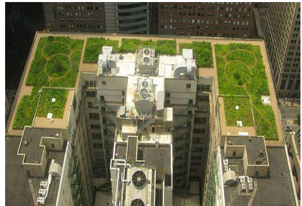
Toiture végétalisée (source: pinterest)
