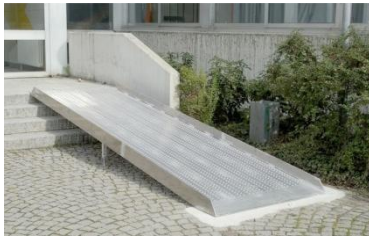
Figure 19: une rampe extérieure (source: pinterest)
