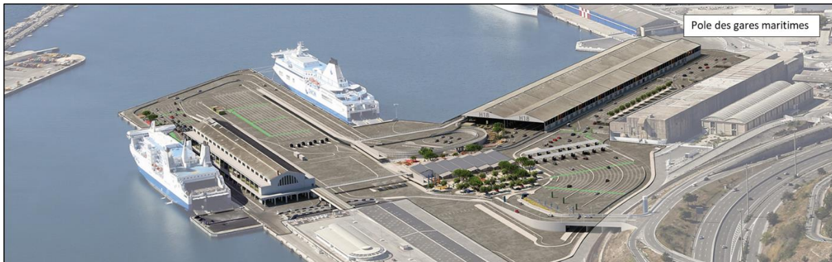
Figure 53 : vue sur le pôle des gares maritimes de Marseille (France) (source : auteur 2021)
