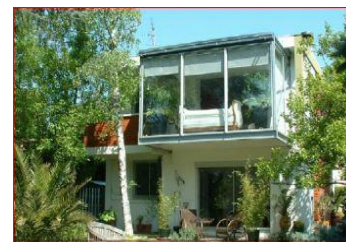
Figure 36 : Avancée de plancher et végétation Architecte F. Ginocchio ,
