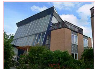
Figure 9 : Les grandes surfaces vitrées sont souvent utiles en zone tempérée (EVA-Lanxmeer, Pays-Bas), source : https://www.techno-science.net/glossaire-definition/Architecture-bioclimatique.html
