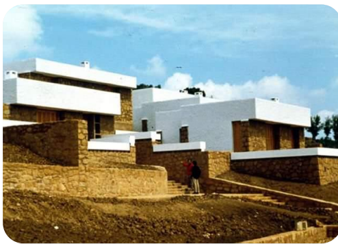
Figure 67 : Habitat semi collectif a wilaya de Médéa Source : Bureau d'étude de l'architecte Mr safar zitoun
