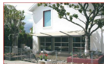
Figure 34 :Vélum Architectes J. Sutter et P.-L. Taillandier , source : protection solaire en ligne
