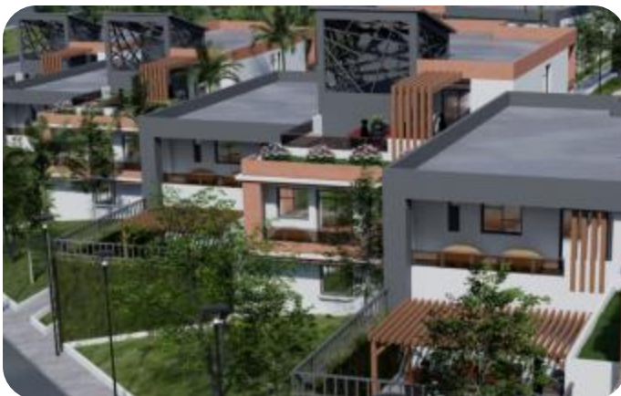
Figure 130 Des protection solaire ( façade postérieure ) source : Auteur
