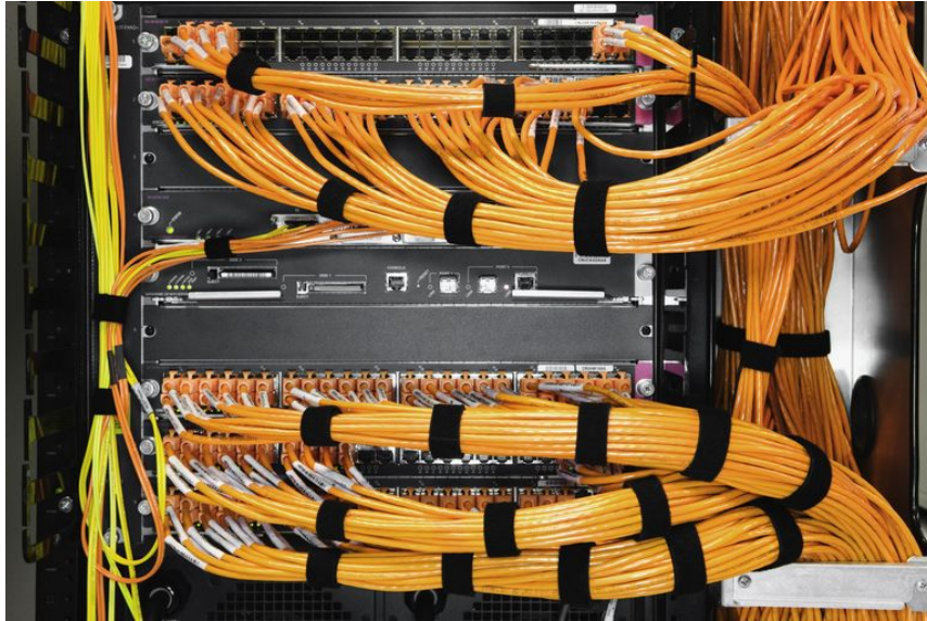
Figure 1.3 : Une armoire de brassage
