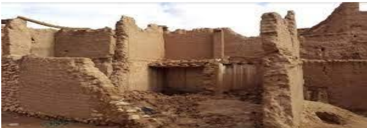
Figure III.15 : Photo réel de Ksar Brika actuellement Source : Google image
