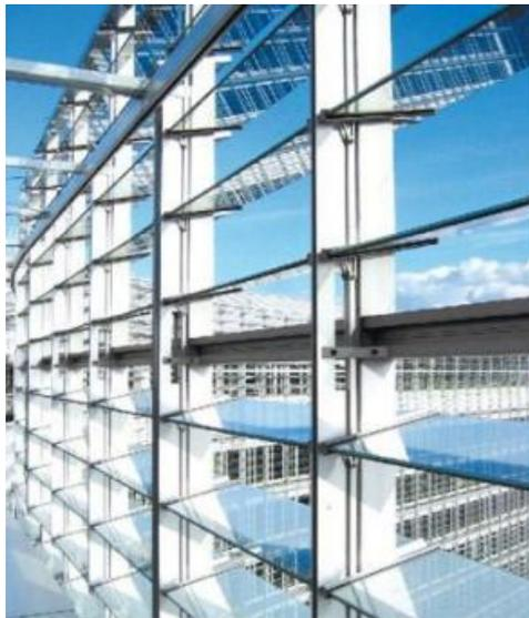
FIG 104. Bâtiment Berlaymont équipé de Double façade composée de lamelles de verre mobiles Grâce aux lames en verre.
