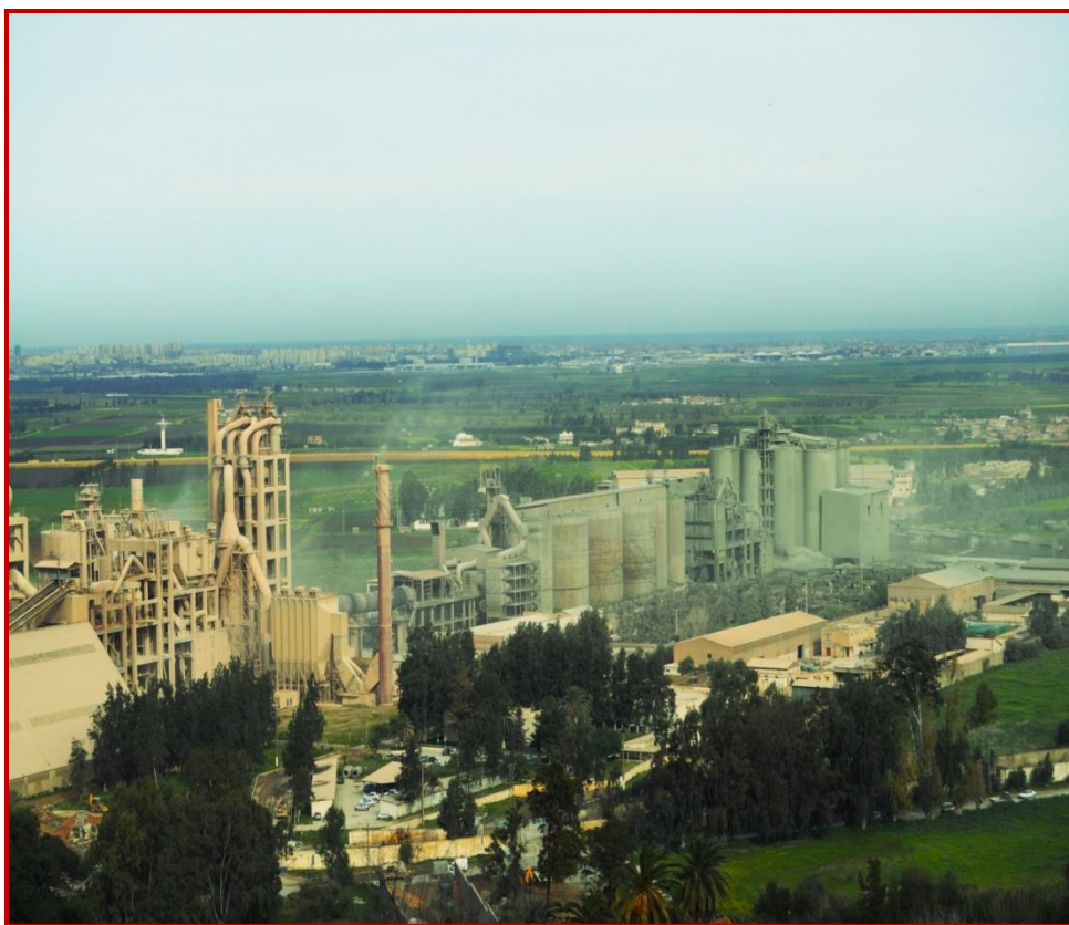
Figure 1.1 : la vue du SCMI.
