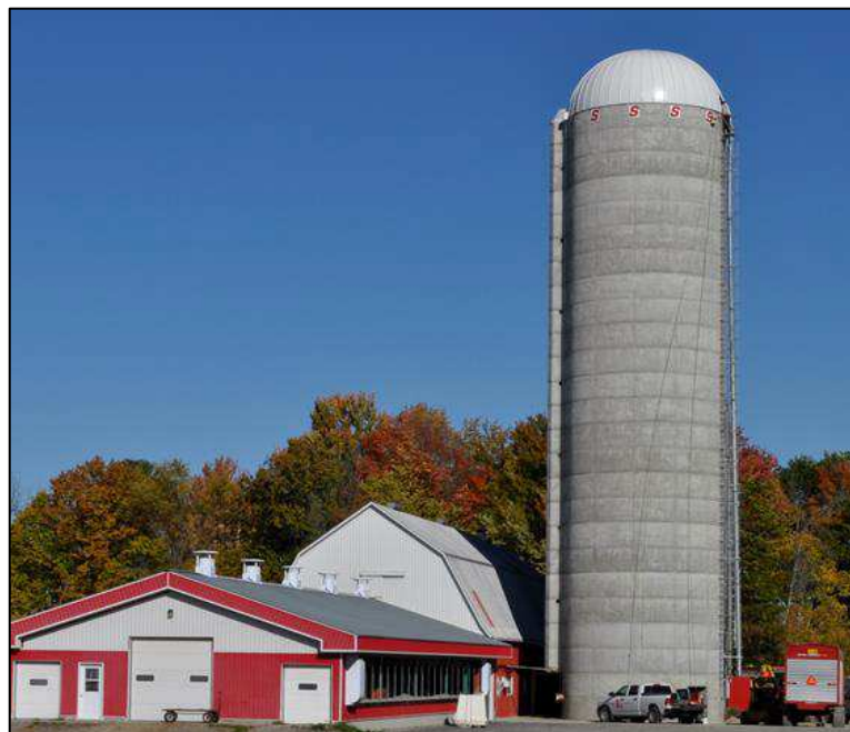
Figure I-2 : image d'un silo tour.
