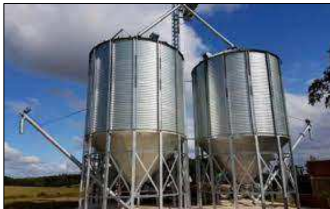
Figure I-4 : image d'un silo à fond conique.
