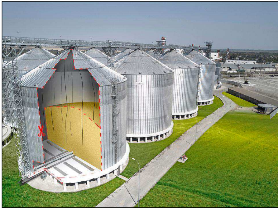
Figure I-3 : image d'un silo à fond plat.
