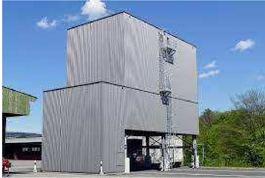
Figure I-5 : image d'un silo modulaire.
