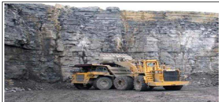
Figure I-3 : exploitation d'une carrière.
