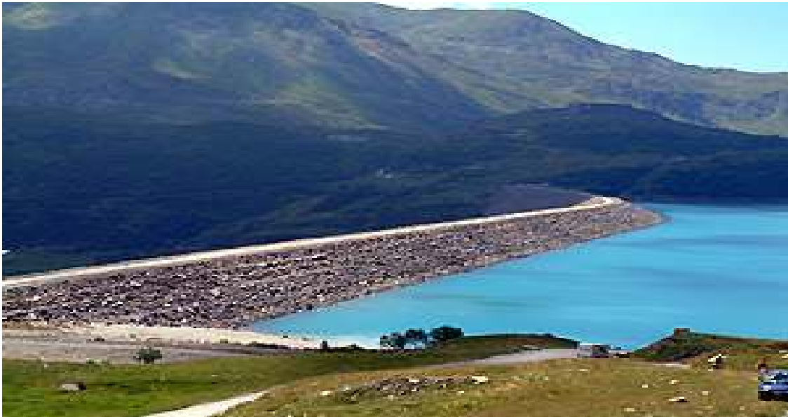
Figure I.10: Barrage en enrochement du Mont Cenis (Alpes).
