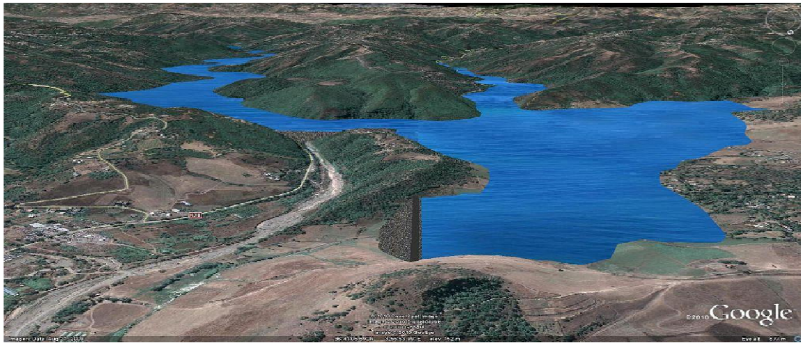
Figure II.1: Vue générale sur le site du barrage.
