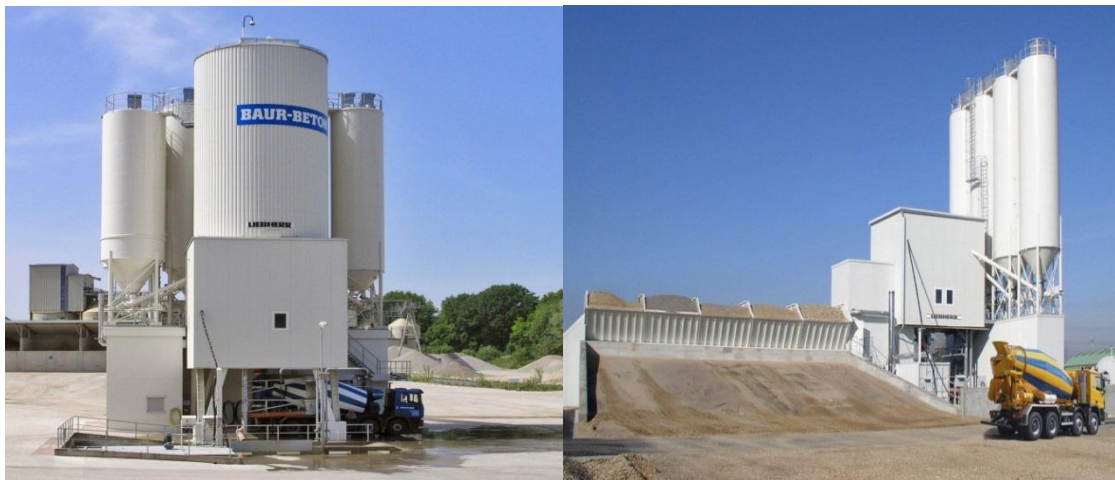
Figure3 : centrale à béton vertical.
