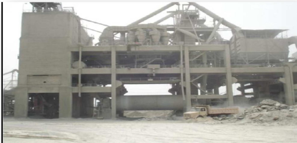
Figure I-14 : broyage de ciment.
