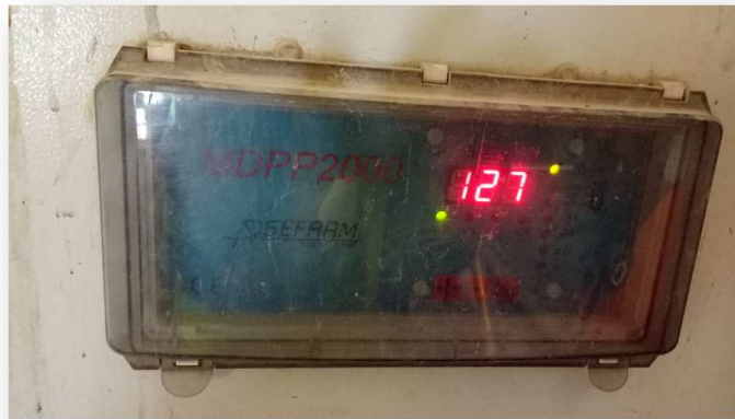
Figure II-5 : transmetteur de pression différentielle.
