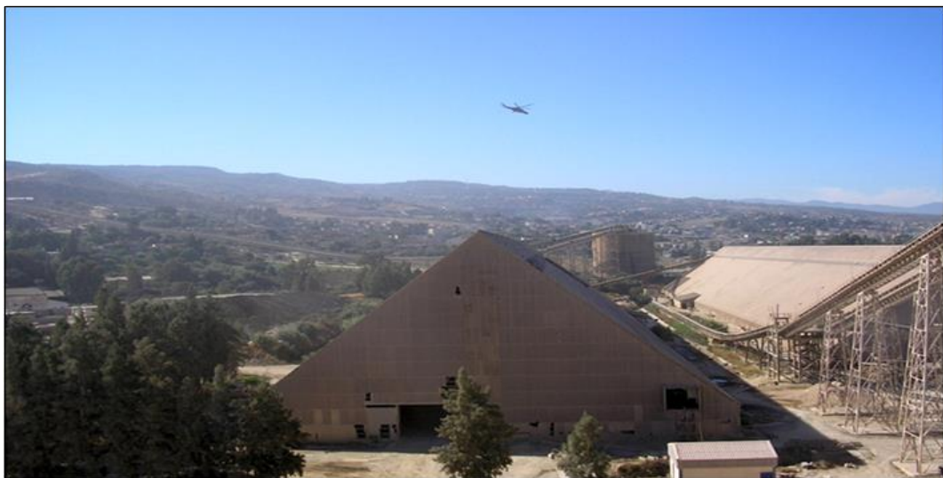
Figure I.4 : Hall de pré homogénéisation.
