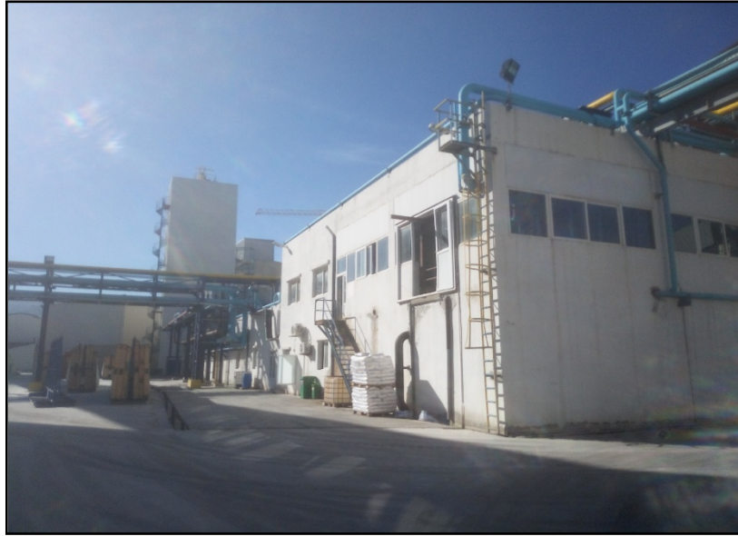
Figure2.1. Station de traitement d'eau.
